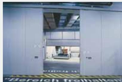
Im Brandfall verschließen zweiflügelige T30-Feuerschutz-Schiebetore automatisch die Anlieferungsebene und verhindern so die Ausbreitung des Feuers.
