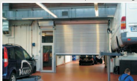
keinen Platz unter der Decke und birgt somit keine Einschränkungen für große Hebebühnen. Hier werden auch verschiedene Arbeitsbereiche miteinander kombiniert, so ist das Tor gleichzeitig ein Schutz vor Kälte und Wärme. Die verglaste Nebentür sorgt für zusätzlichen Lichteinfall in der dahinter liegenden Werkstatt.
