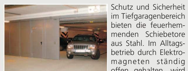
Schutz und Sicherheit im Tiefgaragenbereich bieten die feuerhemmenden Schiebetore aus Stahl. Im Alltagsbetrieb durch Elektromagneten ständig offen gehalten, wird im Falle eines Brandes die Stromzufuhr über Rauchschalter unterbrochen: Das Tor schließt automatisch. Schlupftüren ermöglichen einen Durchgang für den separaten Personenverkehr und sind auch als Fluchtweg geeignet.
